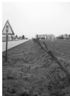
Merlon et fossé en bordure de la RD6015 au sud de la parcelle
