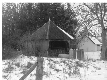
1 : ancien manège de 75m 2 environ Murs en pans de bois et en partie en torchis Couverture en ardoises
