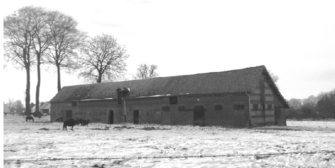
4 : ancien bâtiment agricole de 245 m 2 Brique en façade et brique et silex sur pignon Couverture en ardoises et en tuelles
