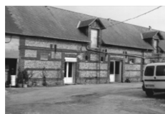
3 : bâtiment de 200 m 2 environ Murs brique et silex Couverture en ardoises
