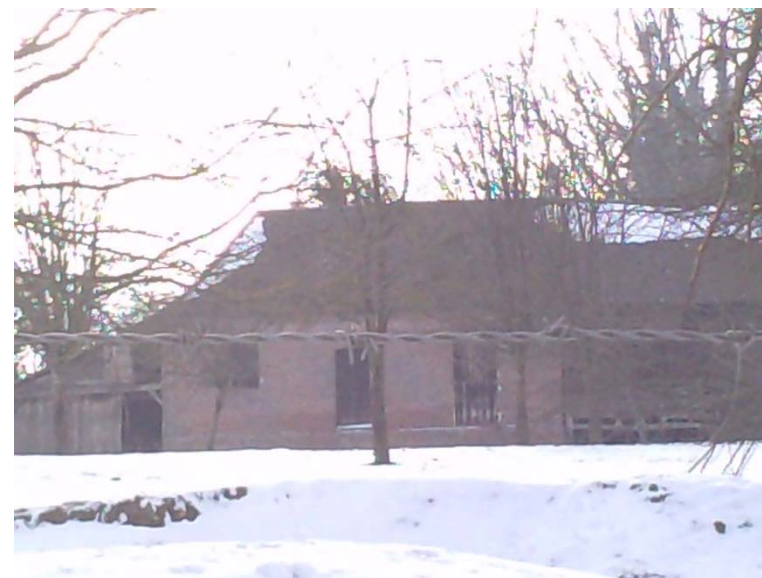
8 : ancien bâtiment agricole de 170 m Façade en brique Une partie du bâtiment en pans de bois (ancienne charreterie) Couverture en ardoise
