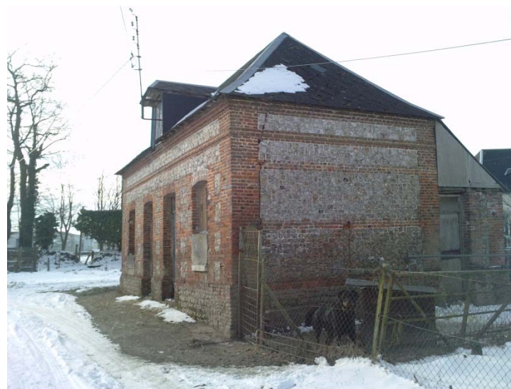
4 : construction inoccupée de 63 m 2 Brique et silex Couverture en ardoises avec lucarne
