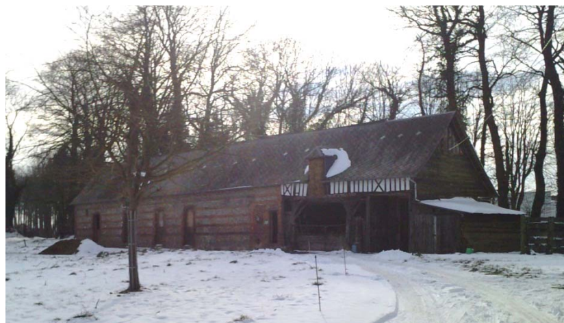
5 : Bâtiment en deux parties de 220m 2 : - Ancien bâtiment d'élevage : Brique et silex - Charreterie en pans de bois Couverture en ardoises avec lucarnes
