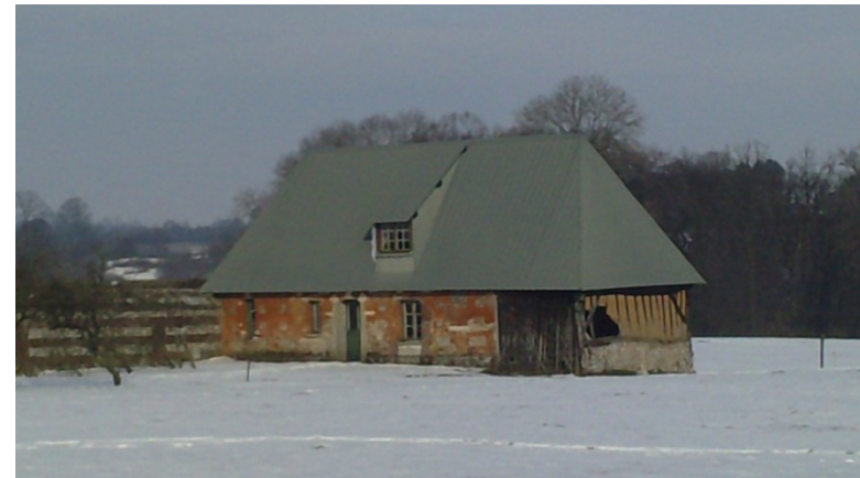
7 : ancienne construction de 90 m 2 Façades et soubassement en pierre, pignon en pans de bois/torchis Couverture en tole
