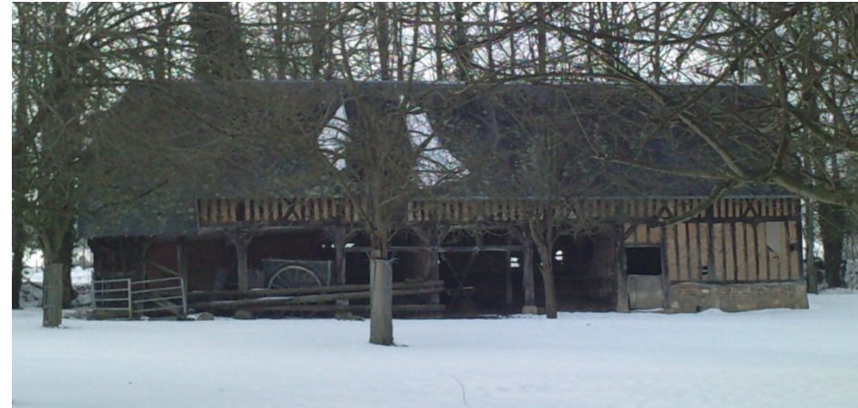
6 : ancienne charreterie de 130 m 2 Murs en pans de bois / torchis Soubassements en pierre Couverture en bac acier
