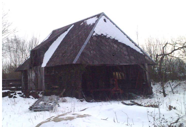
2 : ancienne charreterie de 60 m 2 environ Murs Pans de bois et en partie en torchis Couverture en ardoises
