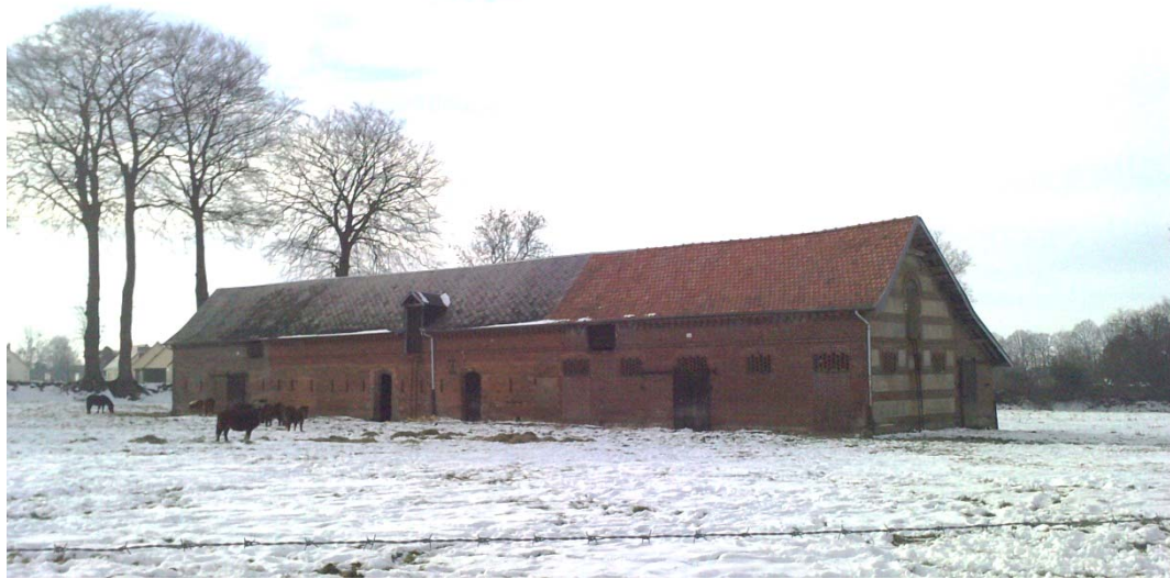
3 : ancien bâtiment agricole de 245 m 2 Brique en façade et brique et silex sur pignon Couverture en ardoises et en tuiles
