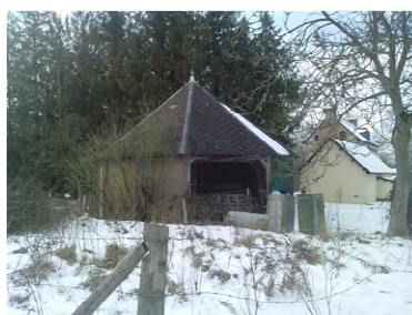
1 : ancien manège de 75m 2 environ Murs en pans de bois et en partie en torchis Couverture en ardoises
