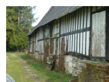
4 : bâtiment de 1610 de 200 m 2 environ Murs Pans de bois Couverture en ardoises
