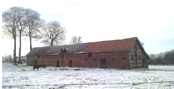
4 : ancien bâtiment agricole de 245 m 2 Brique en façade et brique et silex sur pignon Couverture en ardoises et en tuiles
